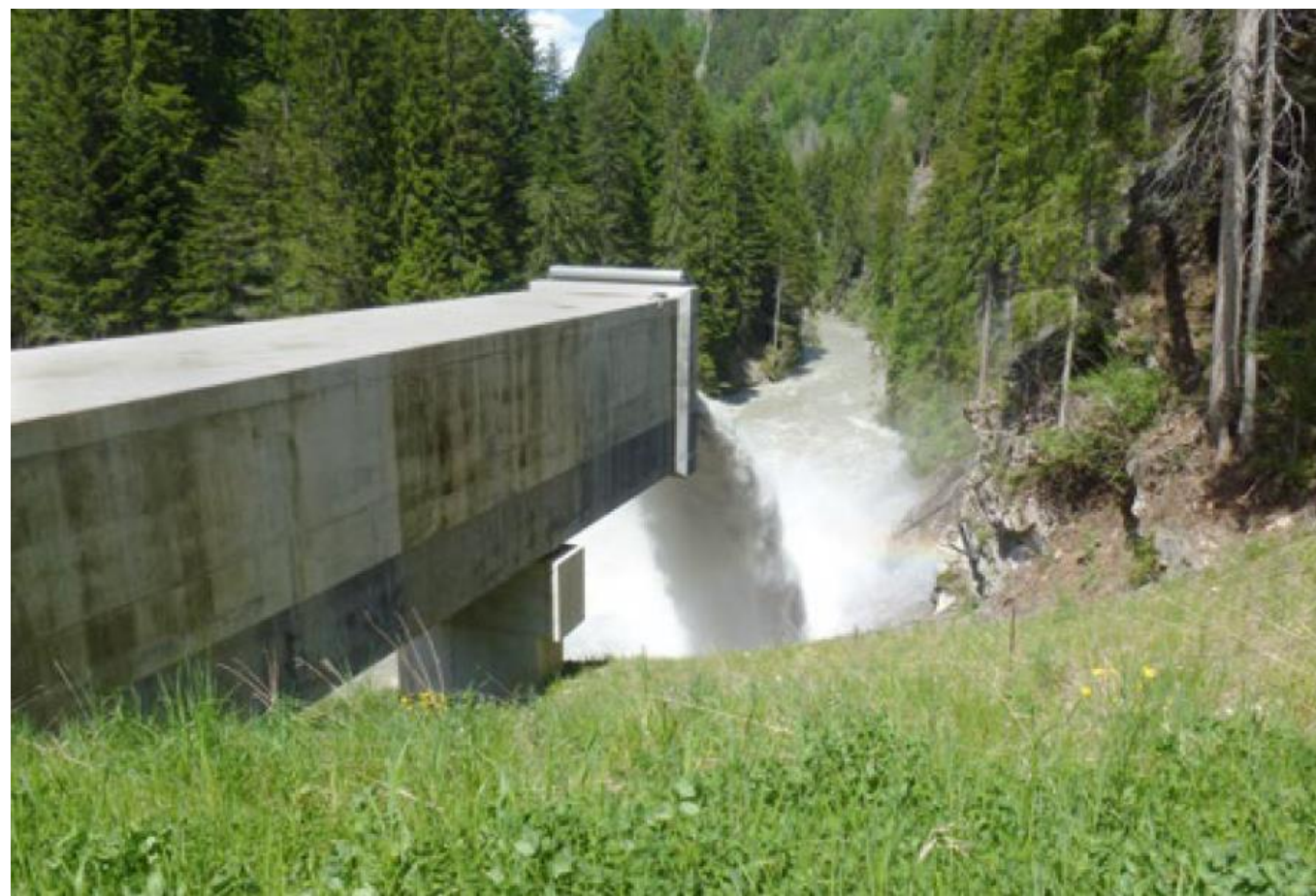
Río Albula, túnel de bypass a la presa Solis para sedimentos, Suiza
