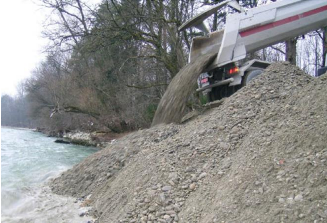
Reposición de sedimentos en el río Reuss, aguas abajo de la presa de Bremgarten, Suiza
